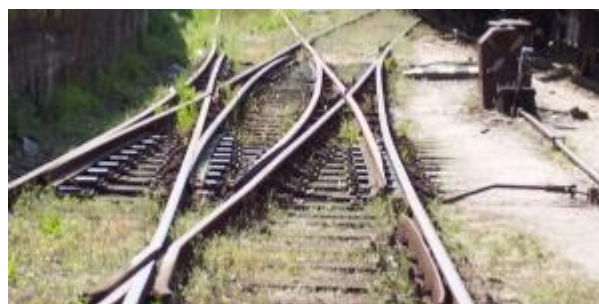
Křižovatková výhybka na nádraží v Dobříši Foto: Ondřej Kučera
